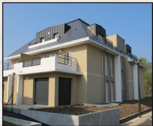
Immeuble à Olivet (45)
